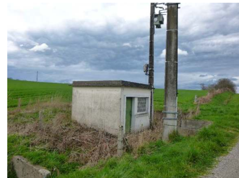
Photographie 16 : Station de pompage le long de la D912 (Source : ENCIS Environnement)
