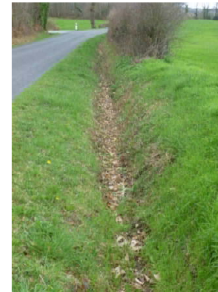
Photographie 4 : Fossé le long de la D84 (Source : ENCIS Environnement)
