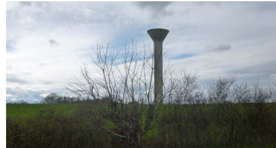
Photographie 15 : Château d'eau (Source : ENCIS Environnement)
