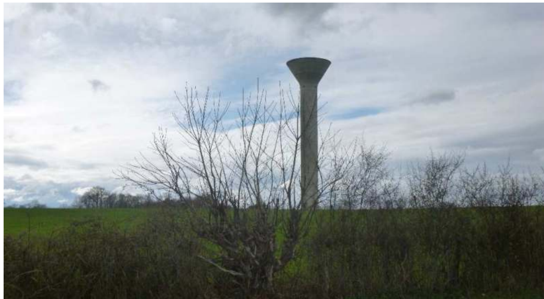
Photographie 6 : Château d'eau (Source : ENCIS Environnement)
