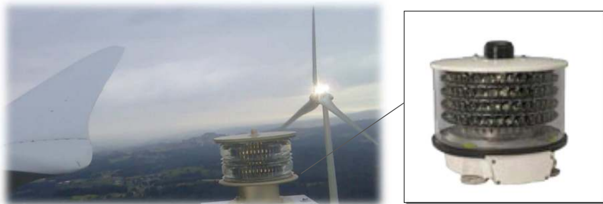
Figure 69 : Balisage d'une éolienne.
