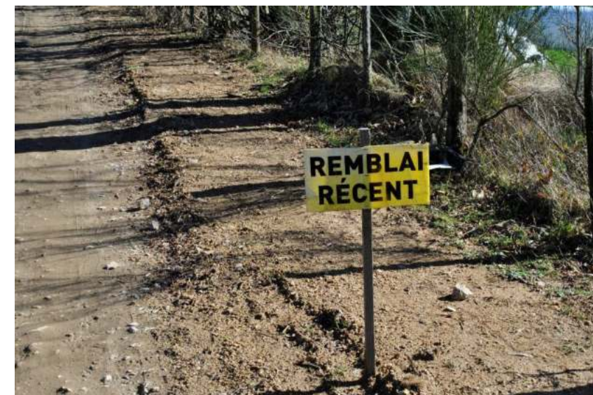
Photographie 34 : Exemple de remblai des tranchées électriques le long d'une piste
