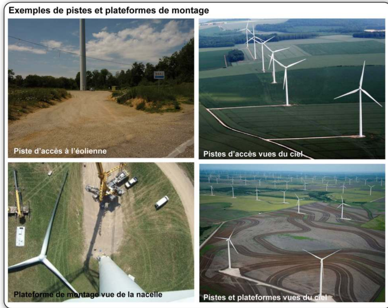
Photographie 20 : Exemples de plateformes de montage et de pistes
