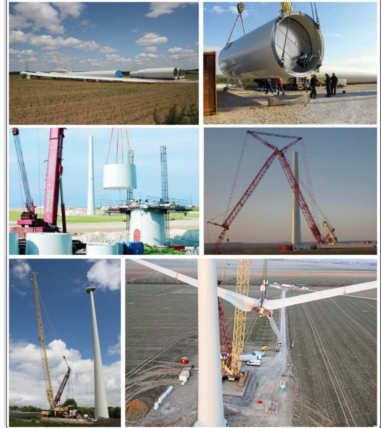
Montage d'une éolienne
