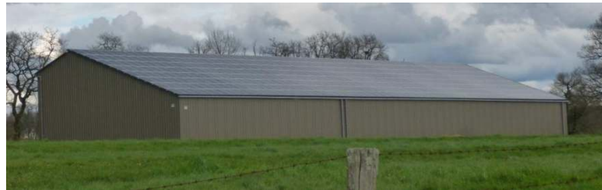
Photographie 18 : Installation photovoltaïque sur la commune de Saint-Sulpice-les-Feuilles. (Source : ENCIS Environnement)
