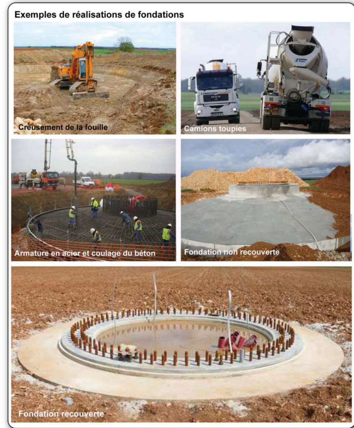
Photographie 30 : Etapes de réalisation d'une fondation d'éolienne
