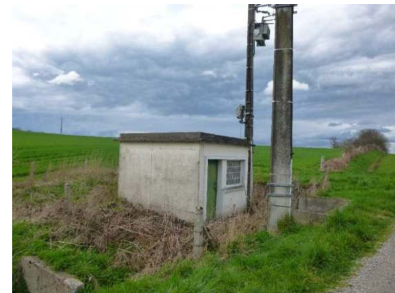
Photographie 8 : Station de pompage le long de la D912 (Source : ENCIS Environnement)
