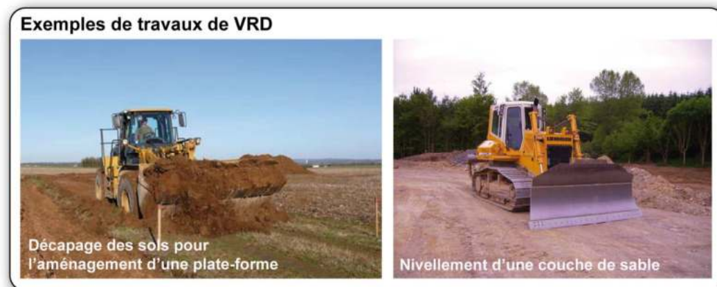
Photographie 29 : Exemples d'engins de travaux de VRD
